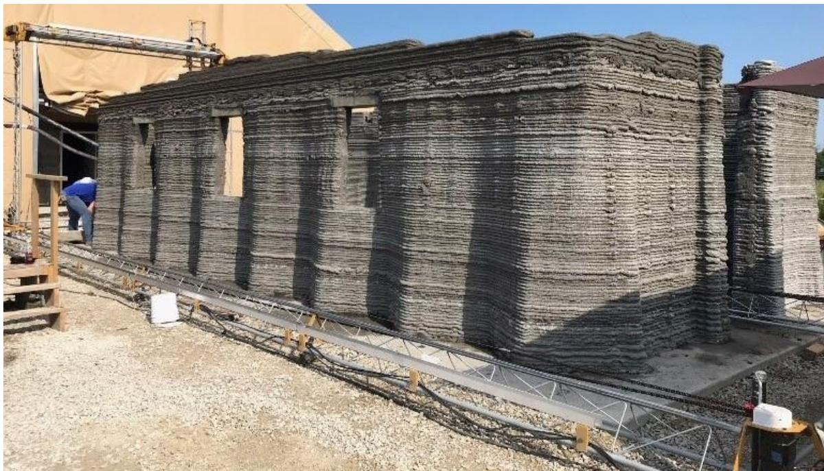
*Figura 20 – Impressão 3D de um edifício*
